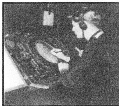
En radarobservatör vid indikatorn (PPI)
